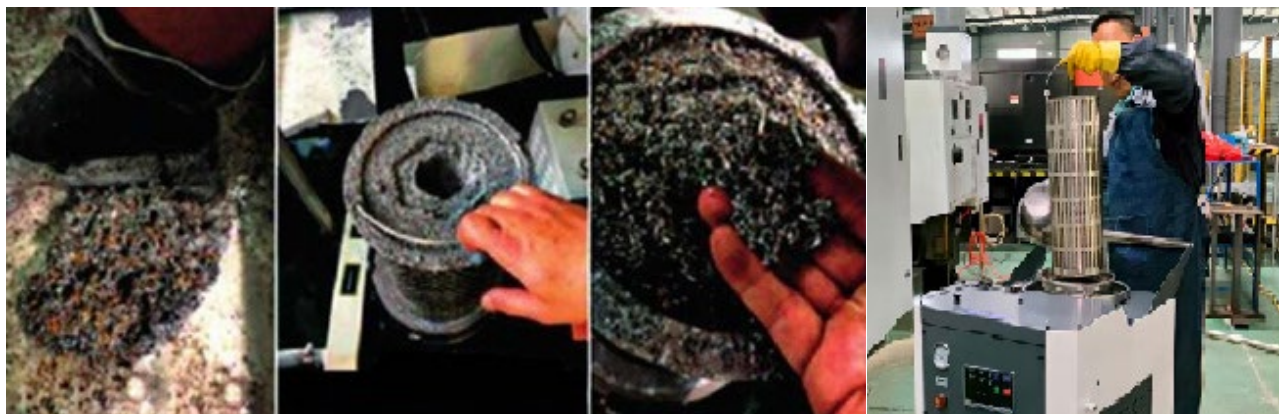
Удаление металлического мусора
